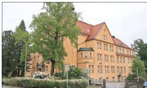
Das zurzeit noch leerstehende Gebäude der Lessingschule an der Henselstraße
