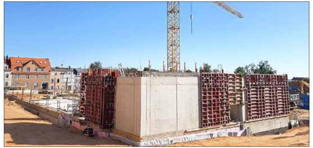
Erste Konturen werden sichtbar: Baufortschritt am Erweiterungsneubau der Lessingschule an der Henselstraße (04.07.2020)
