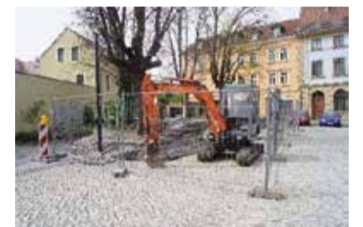
Strom- und Wasserversorgungspoller am Schulplatz für hoffentlich bald wieder stattfindende Feste.
