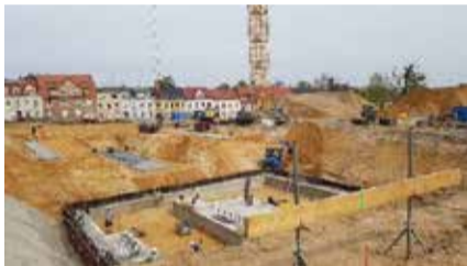
Die Fundamente für den Erweiterungs-Neubau an der Lessingschule werden errichtet.
