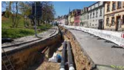
Die Fernwärmeleitungen, u.a. für den Erweiterungsneubau, werden an der Oststraße verlegt.
