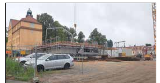
Stand der Bauarbeiten am Erweiterungsneubau Lessingschule am 03.08.2020
