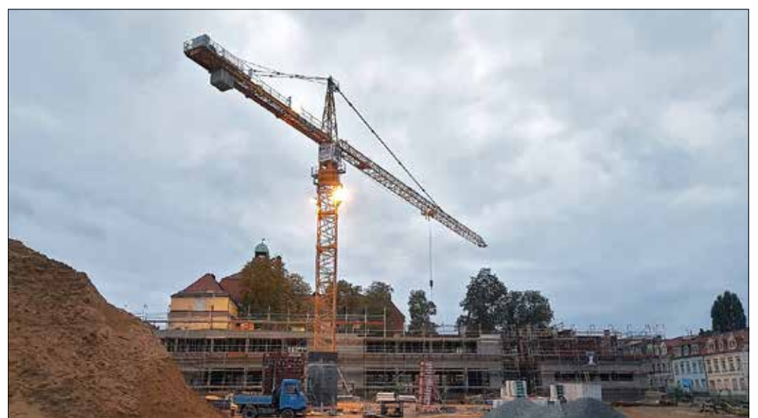
Es wird jetzt Tag und Nacht (in der Woche bis 21.00 Uhr) auf der Baustelle „Lessingschule Henselstraße“ gearbeitet: Stand 08.10.2020
