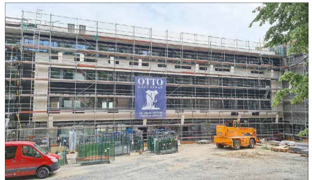
Die Fassadenarbeiten am Erweiterungsneubau an der Lessingschule haben begonnen – Stand 29.06.2021.
