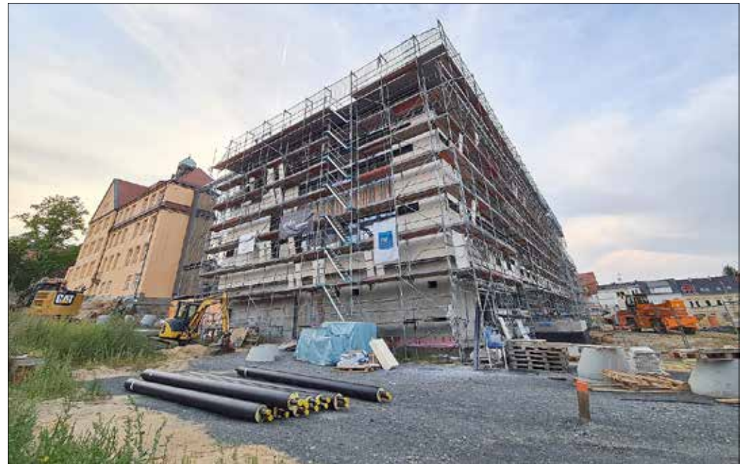
Es geht an der Außenhülle des Erweiterungsneubaus sichtbar voran – Stand 06.09.2021
