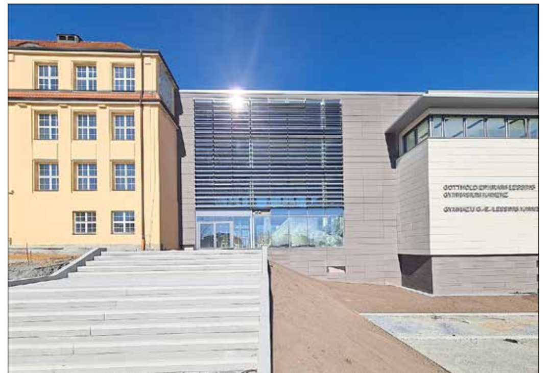
Der neue Hauptzugang in das zukünftige innerstädtische Gymnasium ist geebnet oder besser „getreppt“ – Treppe am Verbindungsbau zwischen altem und neuem Schulgebäude. (12.03.2022)
