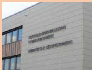
Blick auf den Erweiterungsneubau von der Oststraße
