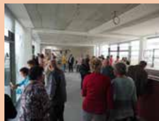
Im Verbindungsbau zwischen alten und neuen Gebäuden.
