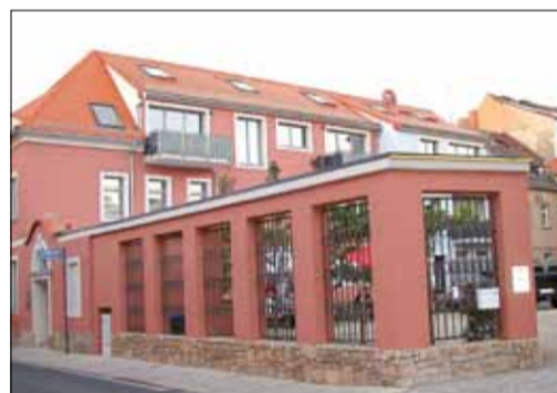
Außengestaltung des Objekts auf der Pulsnitzer Straße
