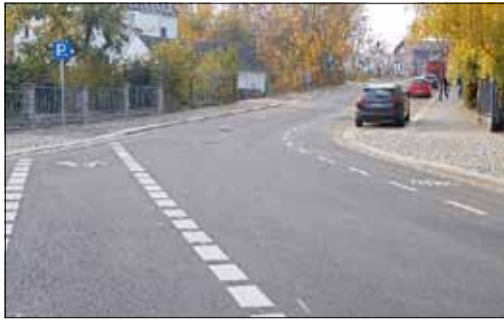
Blick in Richtung Mauerschleuse
