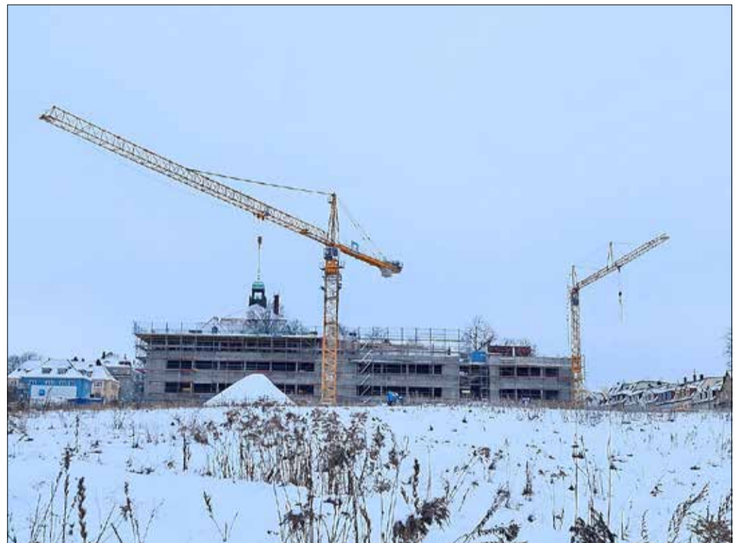
Keineswegs – Stand der Bauarbeiten am 17.01.2021!
