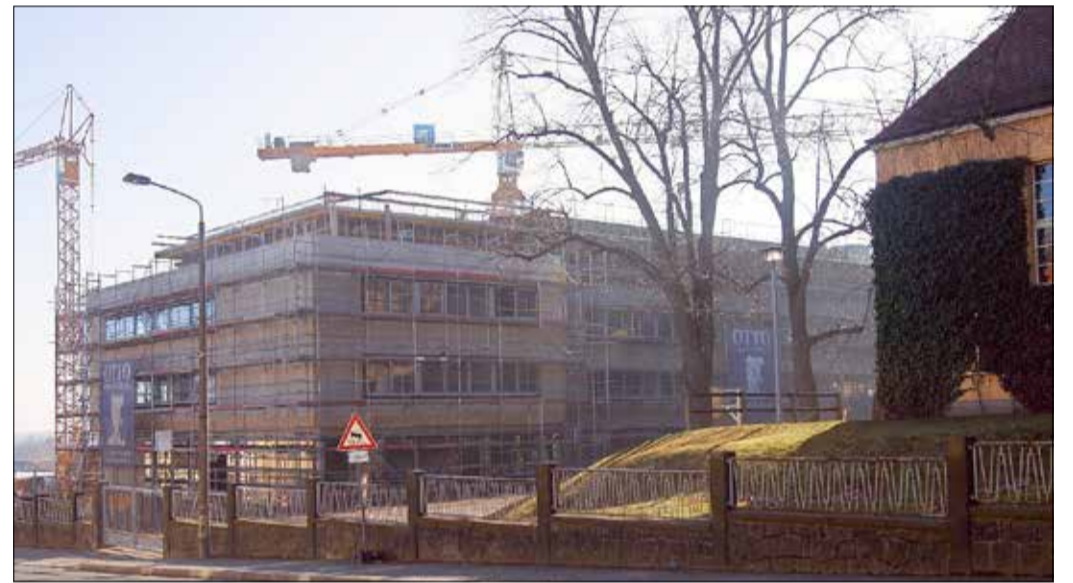
Erweiterungsneubau an der Lessingschule (Stand: 2. März 2021)
