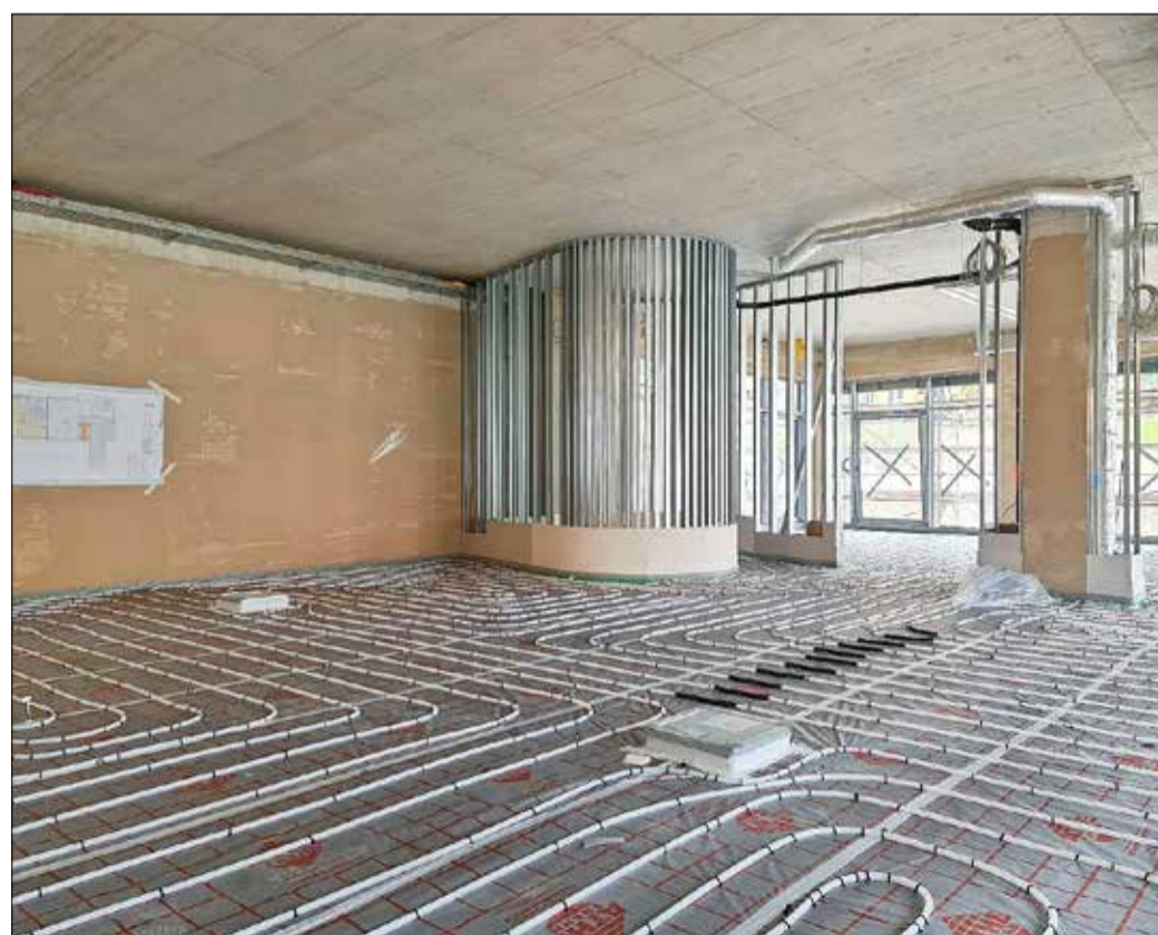
Eine Ansicht der Räumlichkeiten der Stadtbibliothek im Erweiterungsneubau, wie man sie nach Fertigstellung der Räume nicht mehr sehen kann – Stand 21.07.2021.
