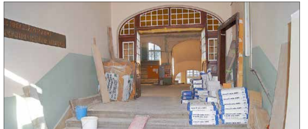
Haupteingang des historischen Gebäudes der Lessingschule am 09.11.2021 - Man sieht, hier wird fleißig gearbeitet.
