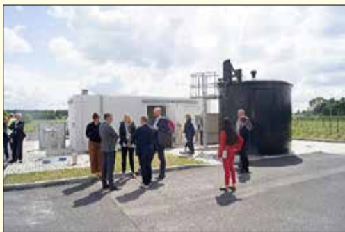
Abpumpstation in Straßgräbchen: Hier erläuterte Jens Philipp von der ewag kamenz die Wirkungsweise.
