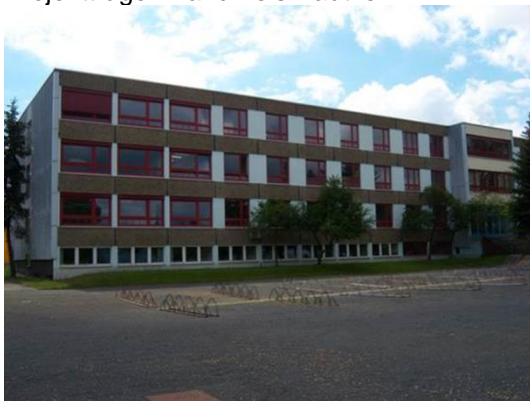
Ansicht Saarstraße - vor der Sanierung 2018
