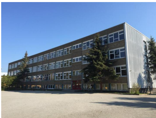
Hofseite vor der Sanierung 2018
