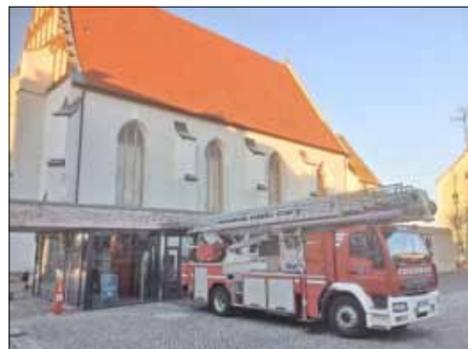
Etwas komplizierter – besonders von der Höhe her – waren die Schäden an der Dacheindeckung an der Klosterkirche St. Annen. Lose Dachziegel fielen zu Boden bzw. blieben in der Dachrinne liegen. Nach Feststellung der Schadenssituation erfolgte in Abstimmung mit der technischen Vertretung des Eigentümers der Kirche, dem Sachbereich Gebäudemanagement der Stadtverwaltung und dem Sachgebiet Ordnung/Sicherheit die Absperrung der Gefahrenbereiche durch die Kollegen der KDK GmbH.
