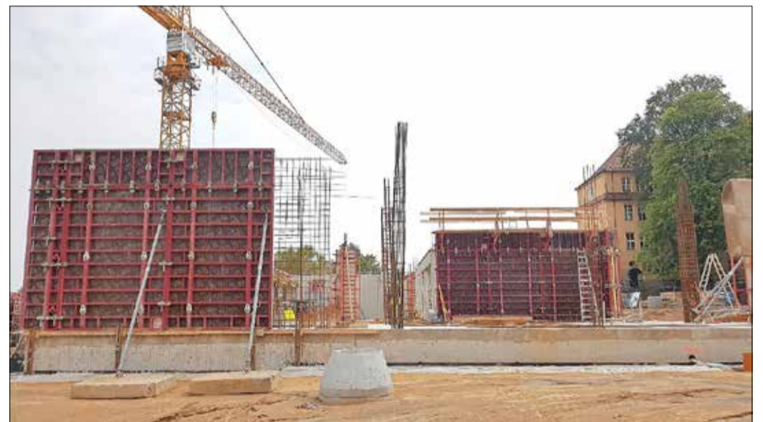
Es geht voran: Erweiterungsneubau an der Lessingschule in der Henselstraße (Stand: 15.08.2020)
