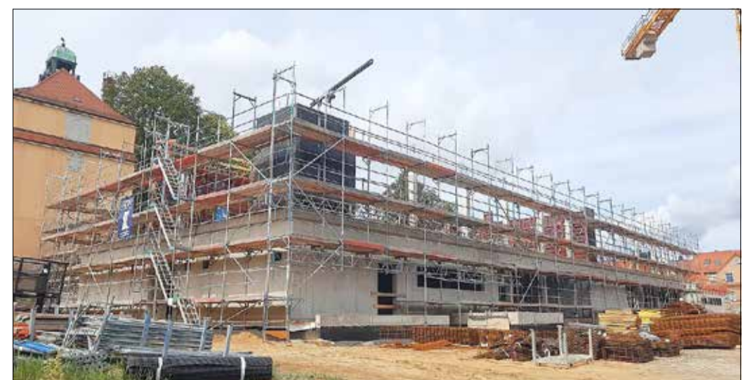
Sichtbarer Fortschritt an der Henselstraße (6. September 2020)
