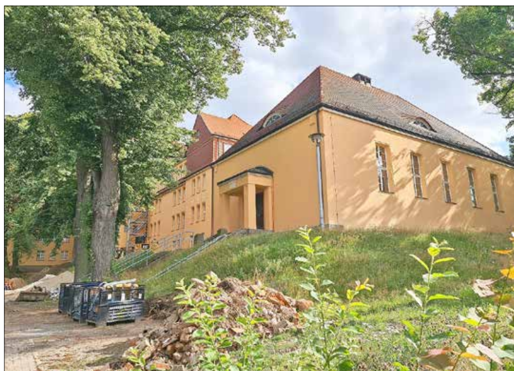
Die Gerüste am Altgebäude im Innenhof des gymnasialen Standortes an der Henselstraße sind gefallen – Stand 19.07.2021
