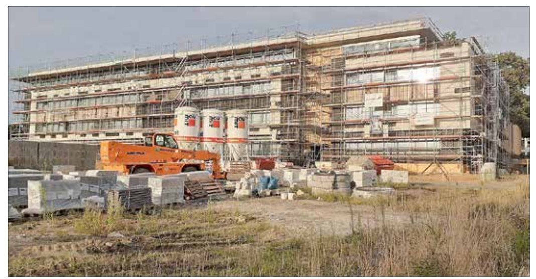
Erweiterungsneubau an der Lessingschule, Stand: 10.08.2021
