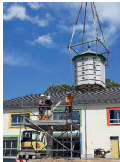
Gegen 14 Uhr wurde das Taubenhaus auf seine endgültige Position gesetzt. Das Fundament erstellt die Fa. Königsbrücker Ingenieure und Straßenbau.
