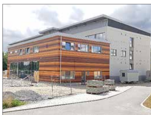
Es geht voran: Gebäude und Sportanlage der 2. Oberschule – 11.07.2020
