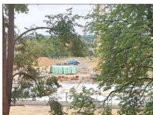
Baufortschritt am Erweiterungsbau an der Lessingschule – 11.07.2020
