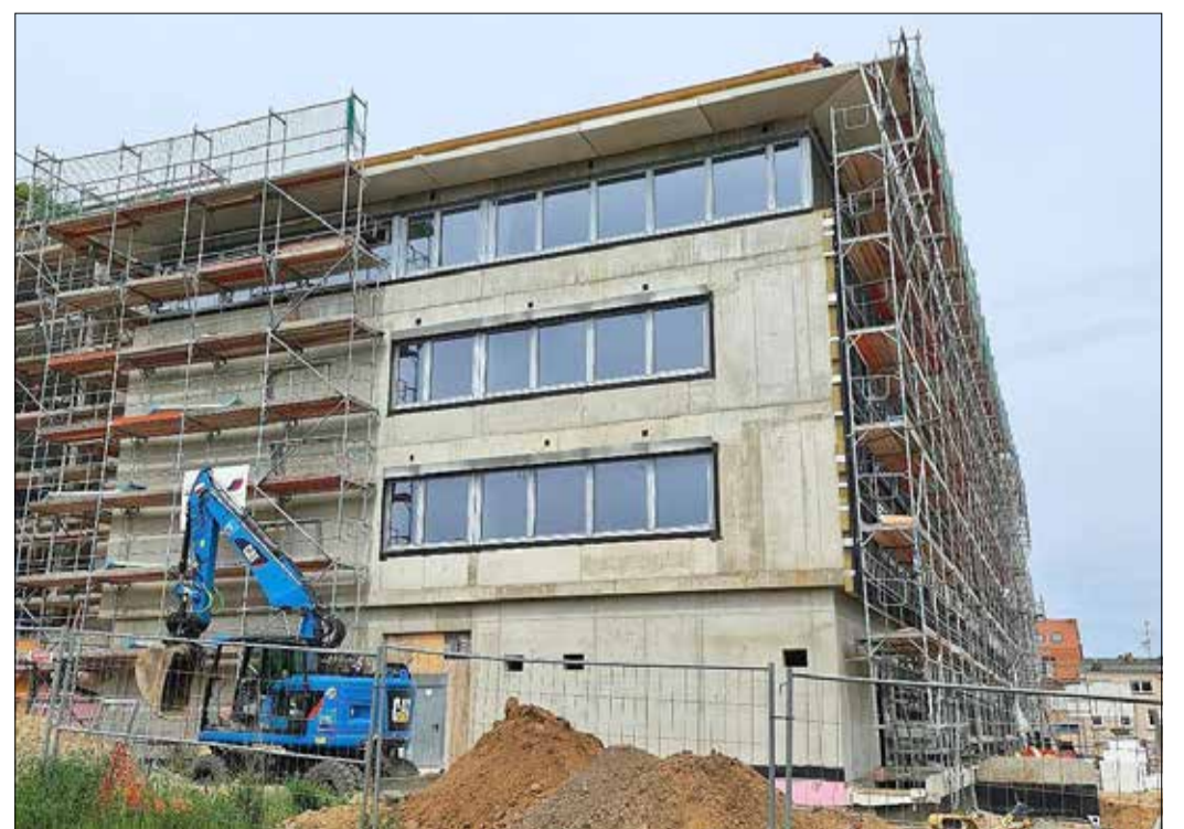
Erweiterungsneubau an der Lessingschule (Stand: 01.06.2021)
