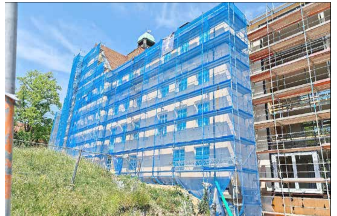
Blau gewandet präsentiert sich das historische Gebäude der Lessingschule. Vorbereitungsarbeiten für Fassadenarbeiten, einschließlich malerische Instandsetzung (Stand: 19.06.2021)
