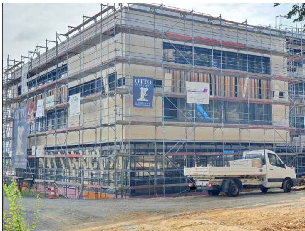
Erweiterungsneubau an der Lessingschule, Stand: 17.08.2021
