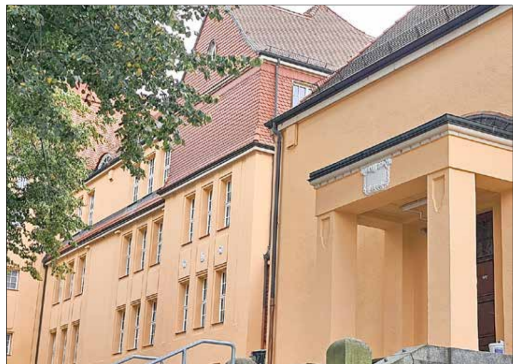
Blick in den Innenhof des Schulkomplexes auf das sanierte historische Gebäude - Stand 29.08.2021
