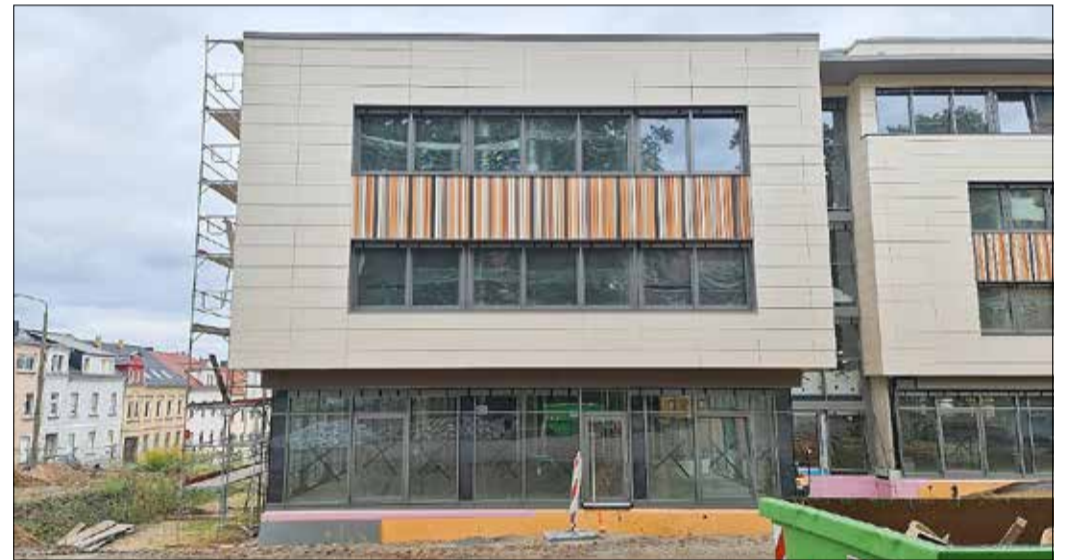
Langsam wird die Fassade am Erweiterungsneubau sichtbar – 19.09.2021
