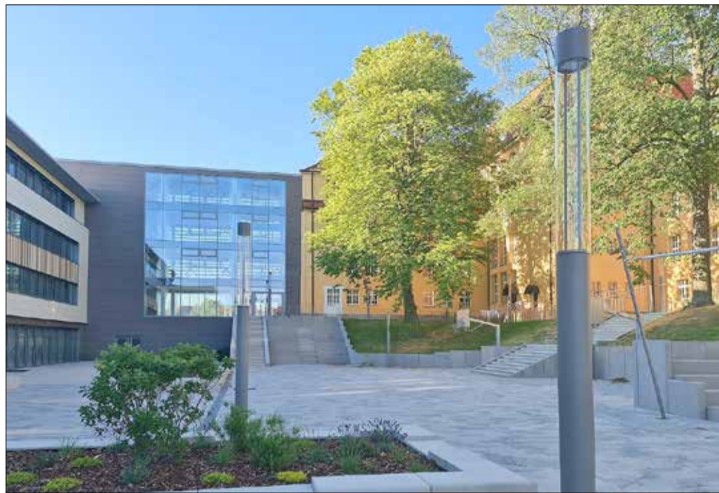
Es werde Licht an der Lessingschule – die neuen Lampen für die Innenhofbeleuchtung wurden installiert. (21.06.2022)
