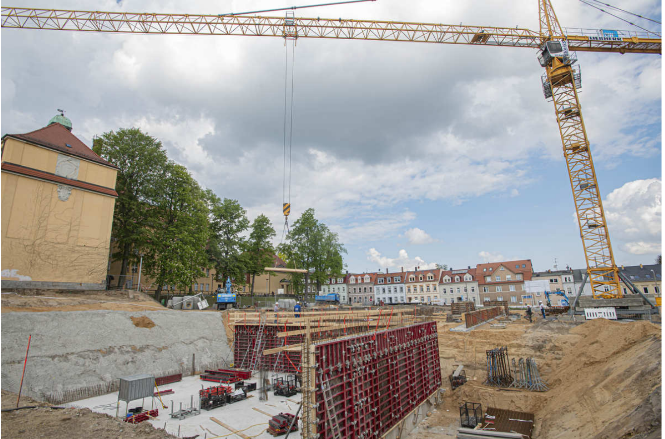
Die größte Baustelle in Kamenz: Hier entsteht der neue Schul-Campus fürs Gymnasium. © René Plaul
