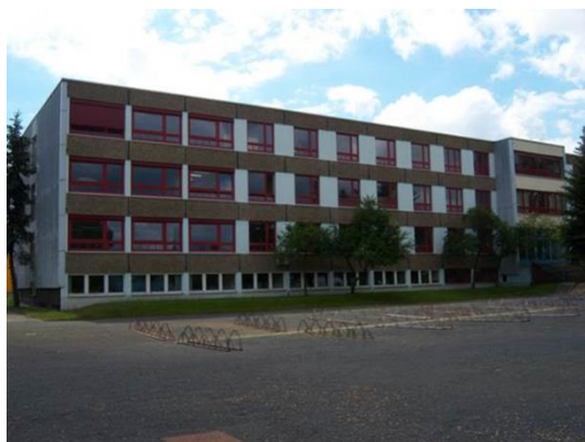
Ansicht Saarstraße - vor der Sanierung 2018
