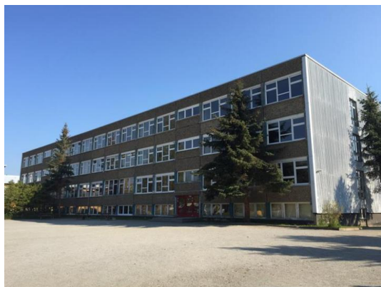
Hofseite vor der Sanierung 2018
